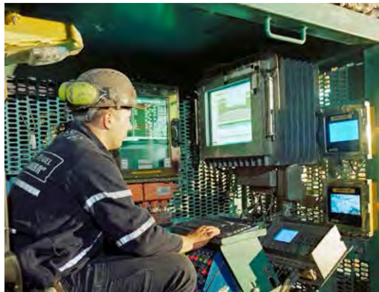
Подземная станция управления
